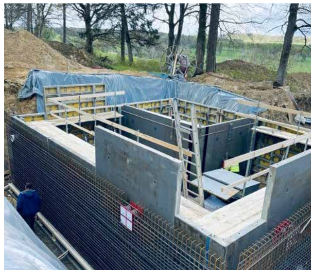
Chantier interkommunale Waasserréseau
