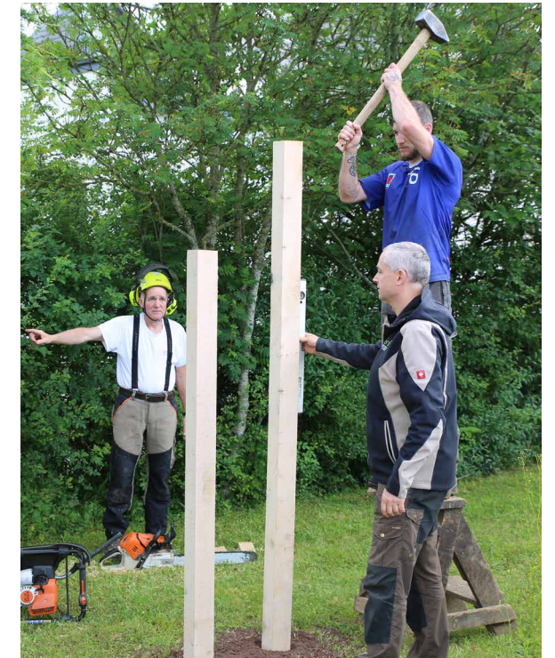
Der Förster und sein Team schlagen Pfähle ein um die Nisthilfen daran zu errichten. ©Commune_de_Fischbach
