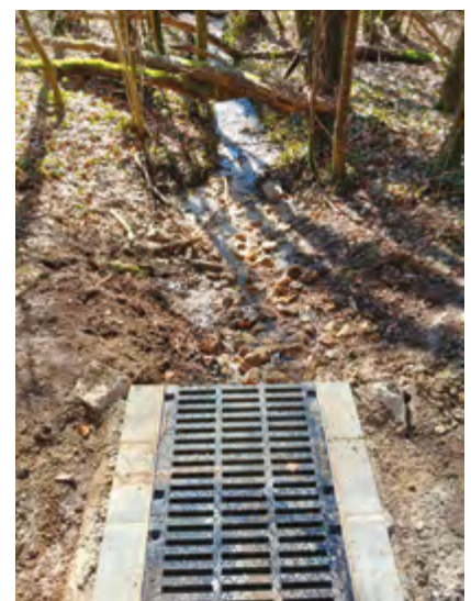
Eine für Organismen durchgängige Rinne ersetzt das frühere Rohr
