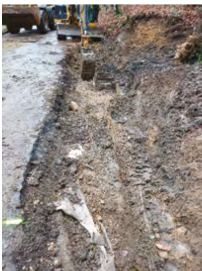
Über Jahrzehnte, durch Verrohrung und Betonschacht zerstörte Quelle wird wieder freigelegt
